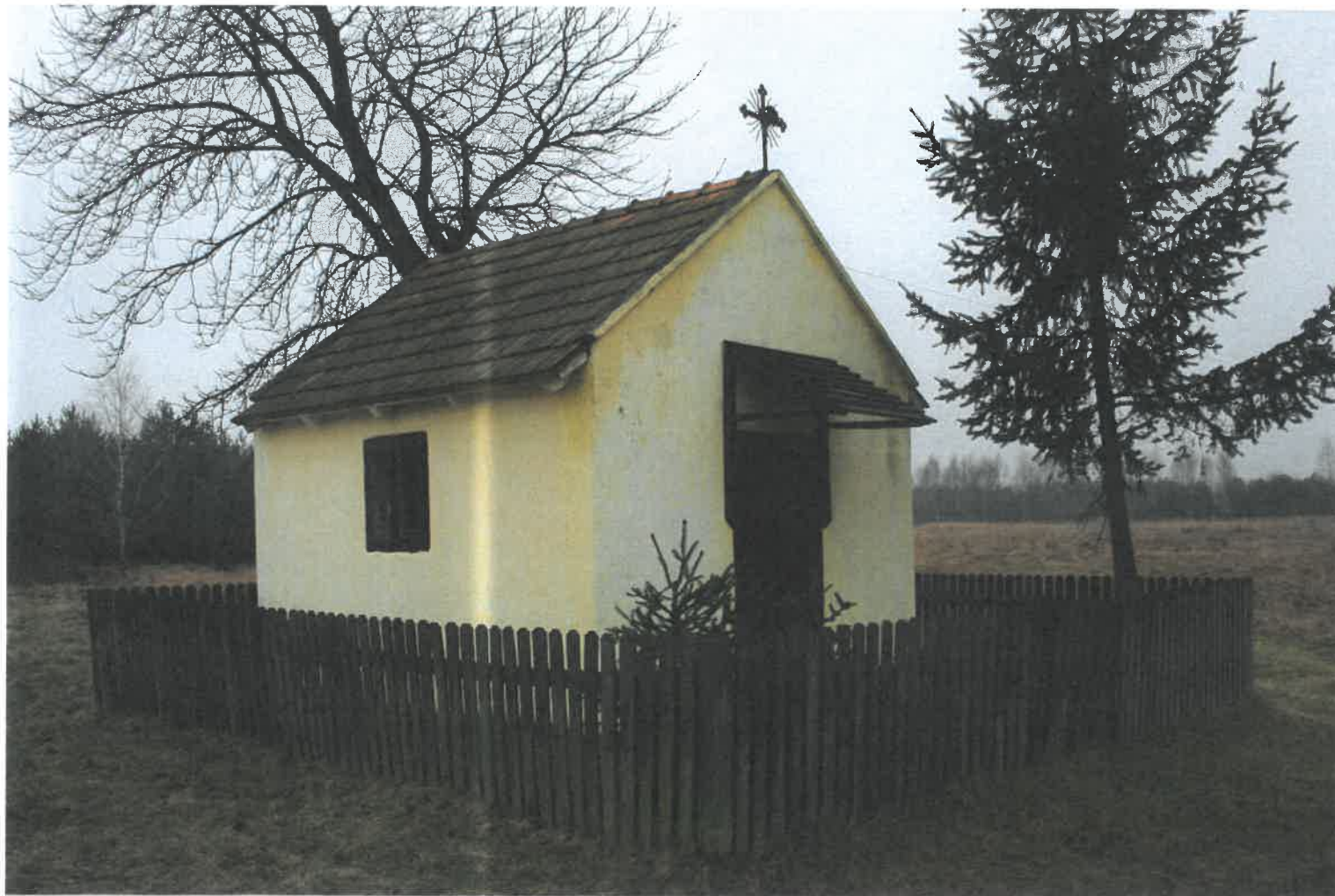
widok od strony drogi
