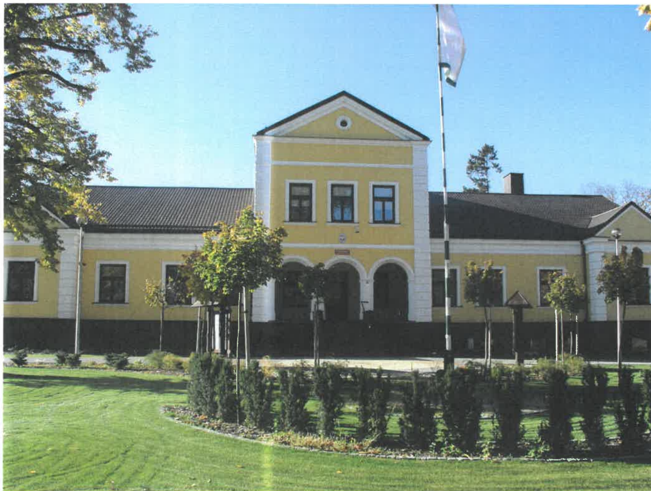
widok od frontu budynku
