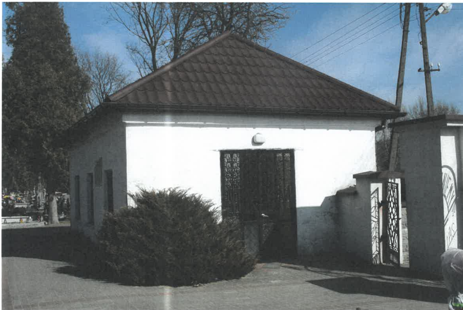
Widok od strony wejścia do kalpicy
