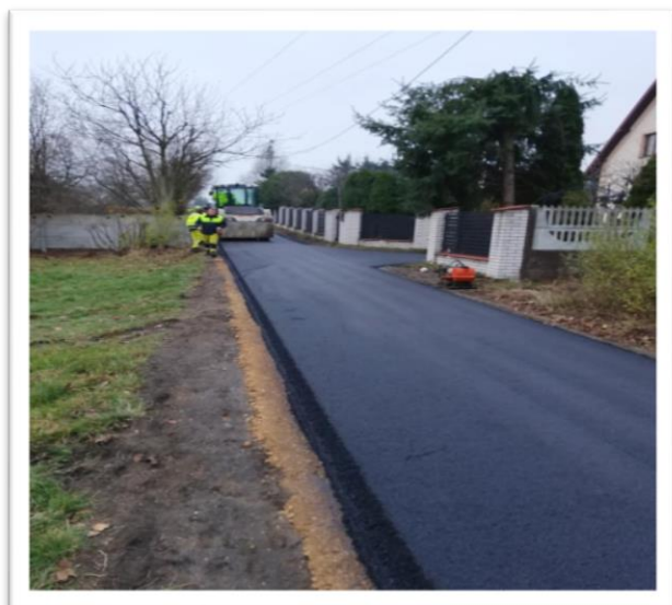
Zdjęcie 12. Wykonanie nawierzchni drogi w Śmiertnym Dębnie.
