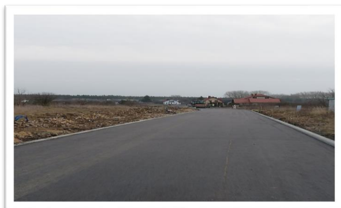
Zdjęcie 10. Przebudowa ul. Narcyzowej i Magnoliowej w Janowie.
