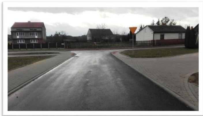
Zdjęcie 8. Przebudowa drogi gminnej ul. Leśnej w Żurawiu.
