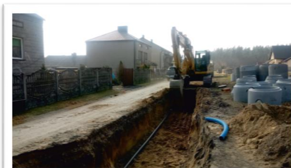
Zdjęcie 7. Budowa kanalizacji w Bystrzanowicach-Dwór.
