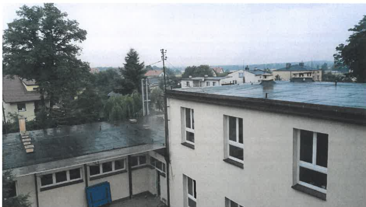
Rysunek 5-4 Widok na północno-zachodnią część budynku.
