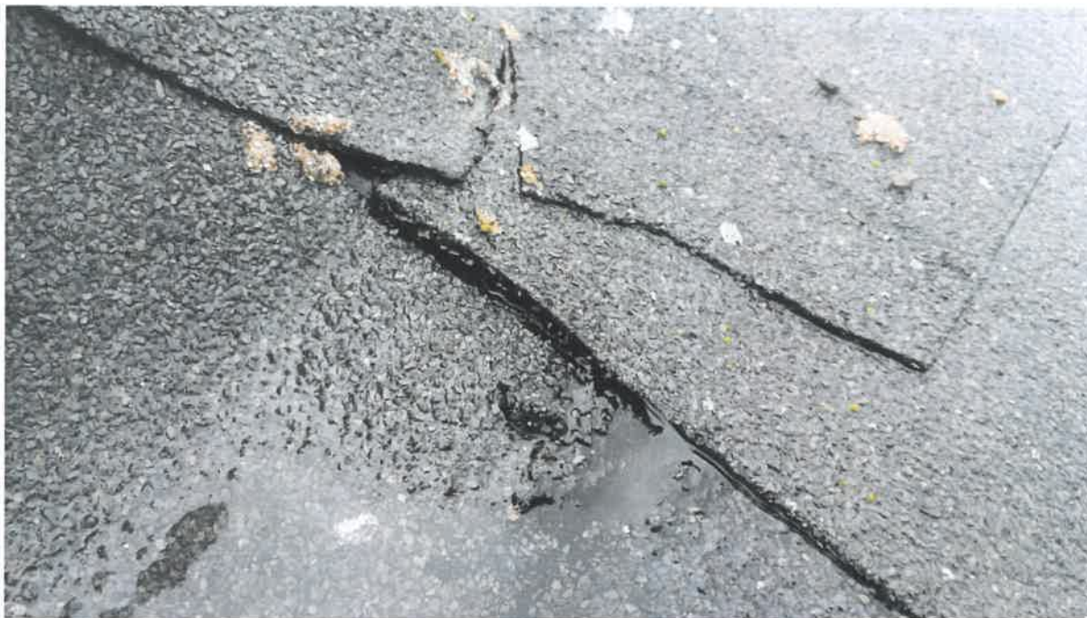
Rysunek 5-7 Złe ułożenie papy w miejscach doszczelnień.
