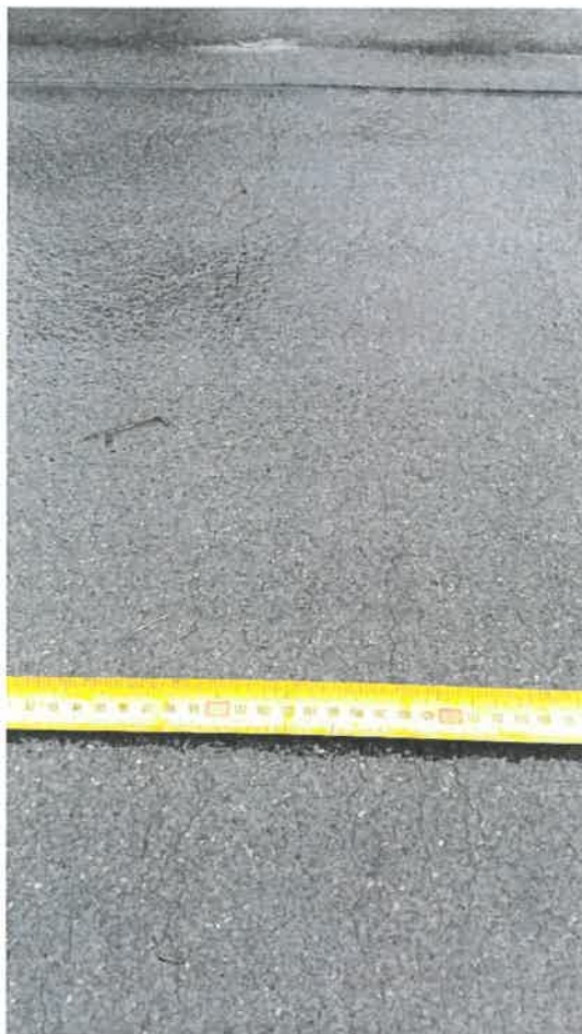
Rysunek 5-1 Fotografia z charakterystycznymi wygięciami na papie
