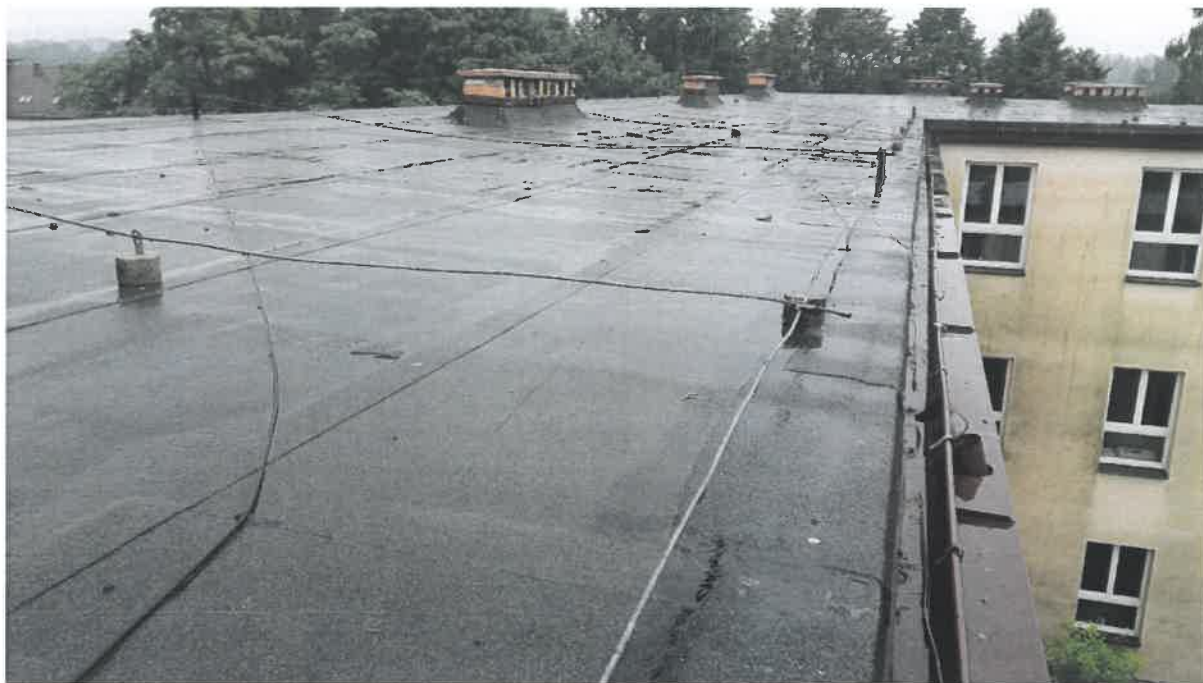
Rysunek 5-5 Najwyżej położona część budynku po stronie wschodniej.
