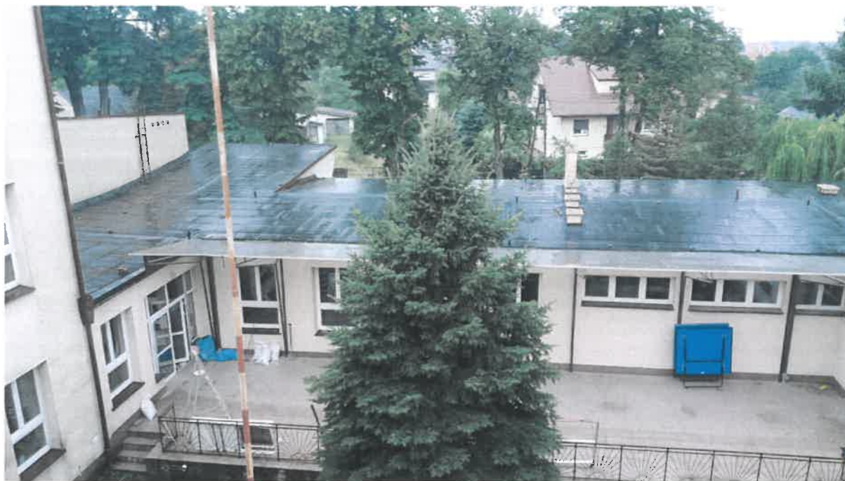
Rysunek 5-3 Widok na zachodnią część konstrukcji
